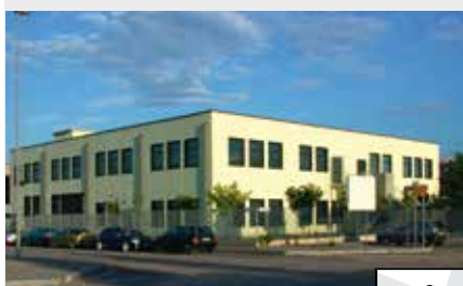
Vista esterna della CAMAR spa
